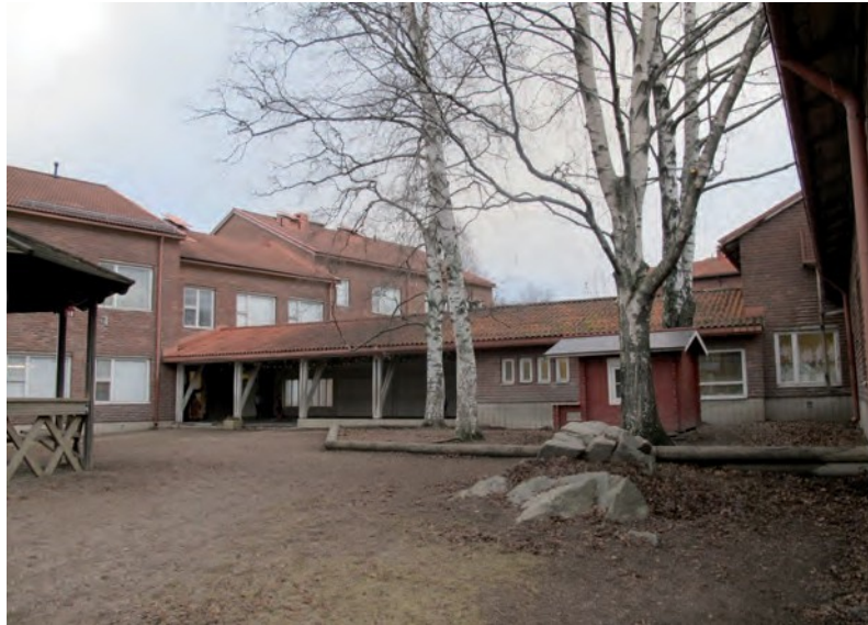
Kuva 30. Piha.alue. Päiväkoteja yhdistää käytävä/katos. Kuva SHi.
