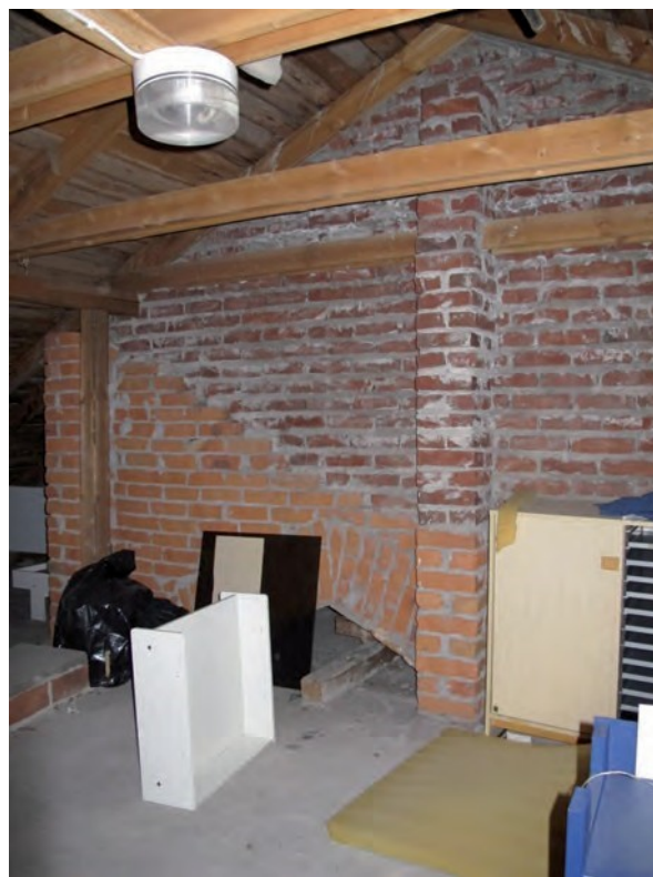
Kuva 64. Väinöläkadun puoleisen siiven korkea ullakko. Kattoraken-teet ovat terveet. Kuva SHi.
