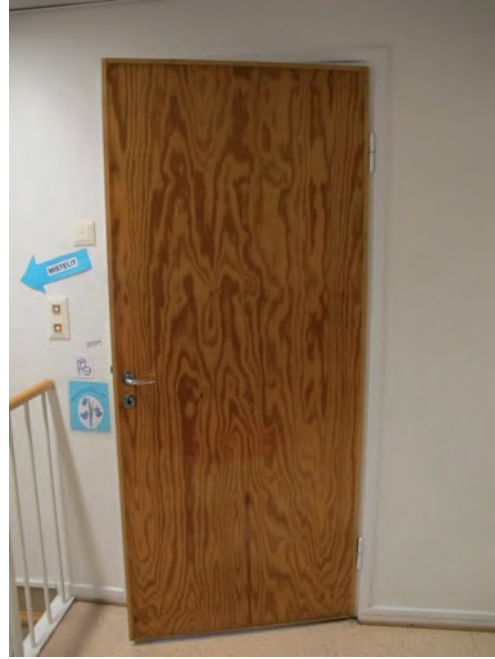
Kuva 49. Alkuperäinen lakattu mäntyvanerilaakaovi.
